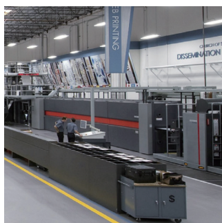
Centro de distribuição
